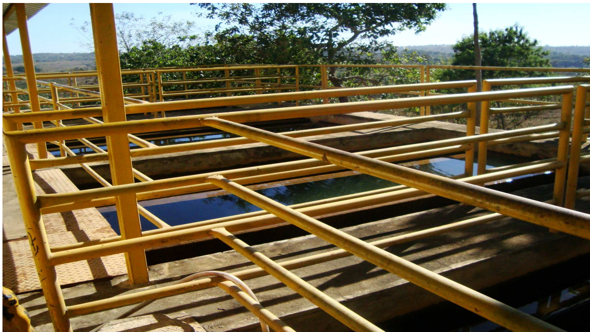
Figura 13: Estação de Tratamento de Água - Uruaçu/GO
