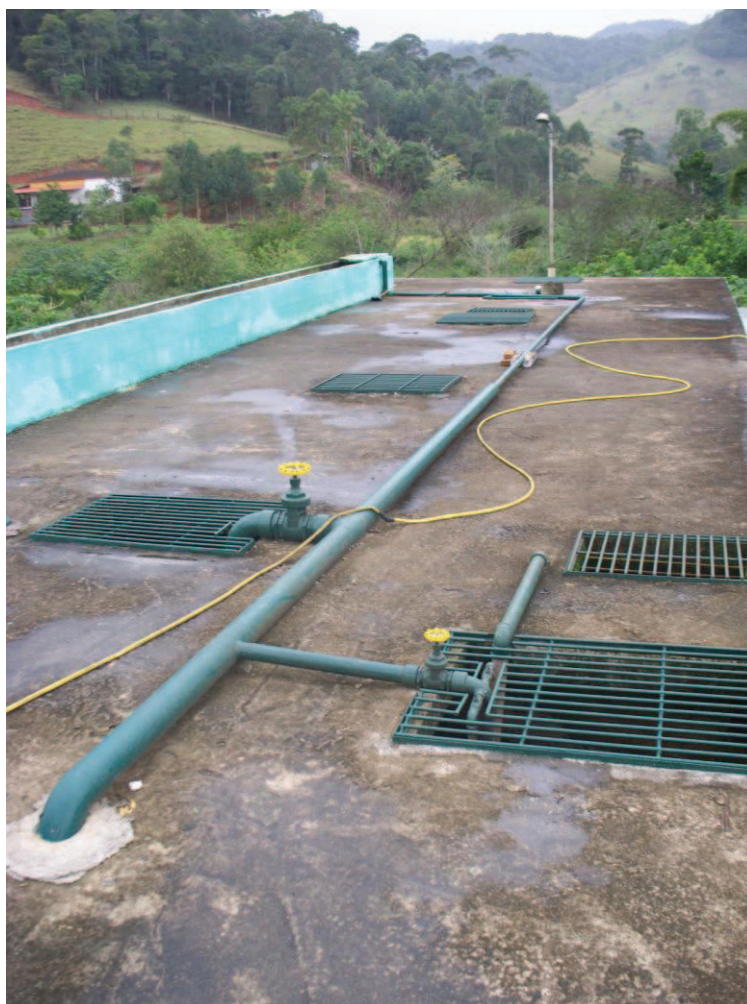
Figura 9 – Vista superior em ETE: Digestor de lodo, Tanque de aeração (A, B e C), Decantador e Calha de retorno do lodo (Direita a Esquerda)
