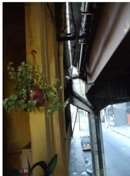
**Figura 72-** Estrutura da Linha Vermelha encostando-se a edificação na Rua Bela. Foto da autora (2013).
