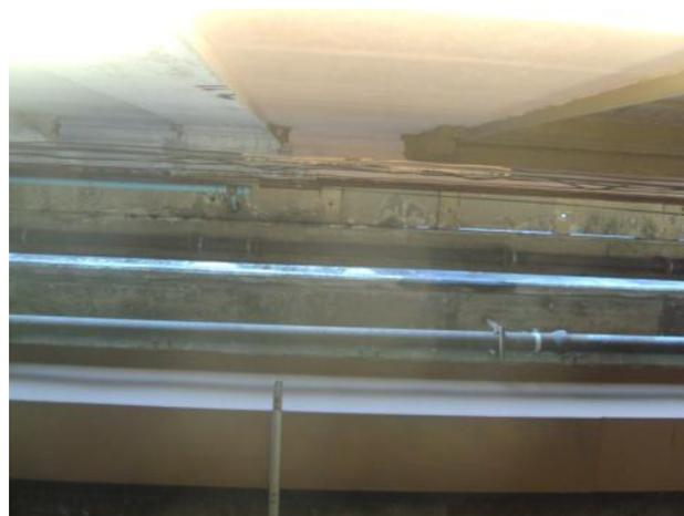
**Figura 45 -** Tubulações e aberturas no tabuleiro da [Linha Vermelha que concorrem para as más condições de acessibilidade da Rua Bela. Foto da autora (2013).
