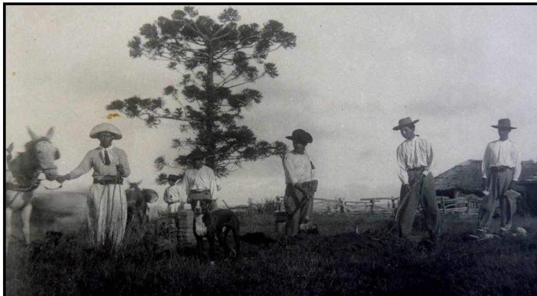
Imagem 12 - Construção de um pilar em Barro Vermelho. Década de 1920.
