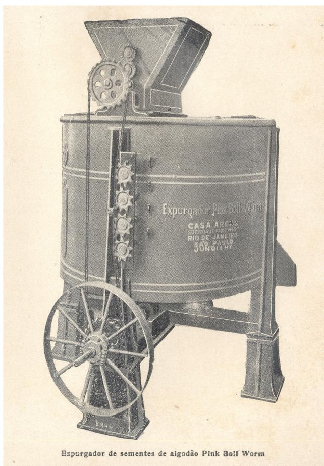
Figura 8 – Máquina desenvolvida por Costa Lima para o expurgo e aquecimento das sementes de algodão. Imagem retirada do livro *A Cultura do Algodoeiro no Brasil*, de Souza, 1921, p. 20.
