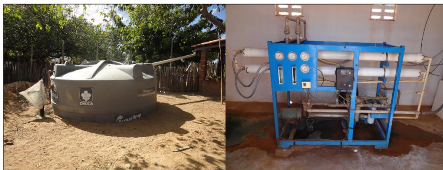
Figura 14 À esquerda: cisternas de coleta de água da chuva. À direita: dessalinizador de água. Município de Russas, Ceará, 2013.
