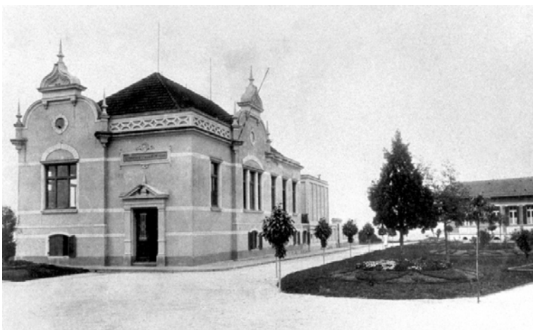
Vista lateral do Instituto Bacteriológico de São Paulo, vendo-se ao fundo um dos pavilhões do Hospital de Isolamento. Algumas Instalações do Serviço Sanitário de São Paulo . São Paulo, Vanorden & Co., 1905. Museu Emílio Ribas.
