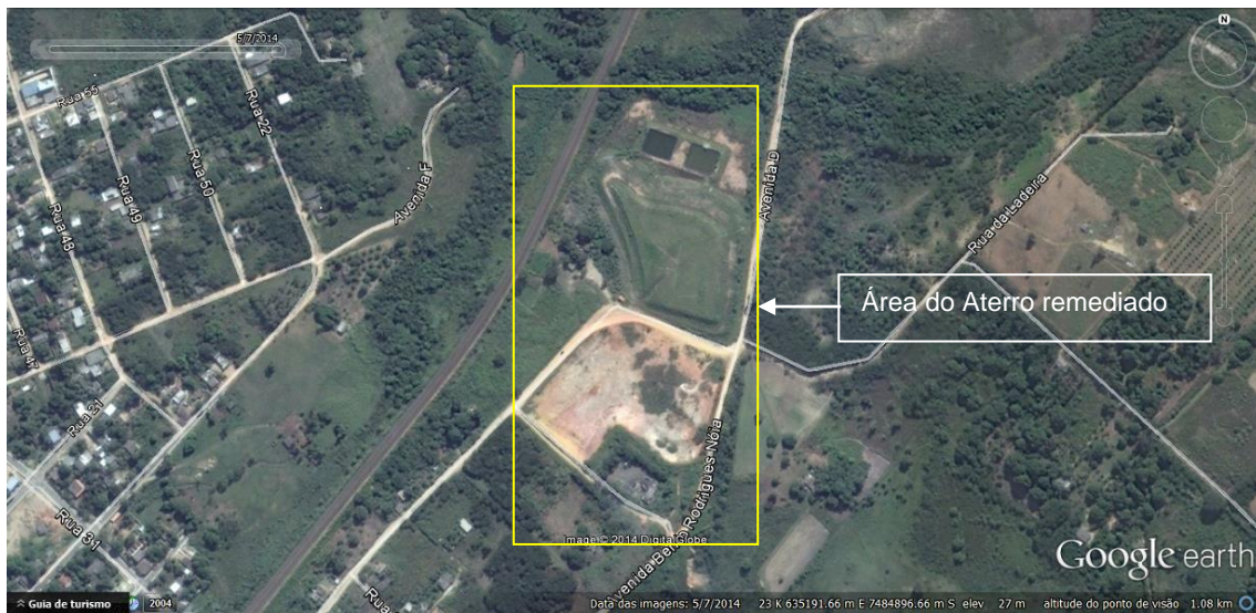
Figura 6 – Área do aterro remediado via satélite.
