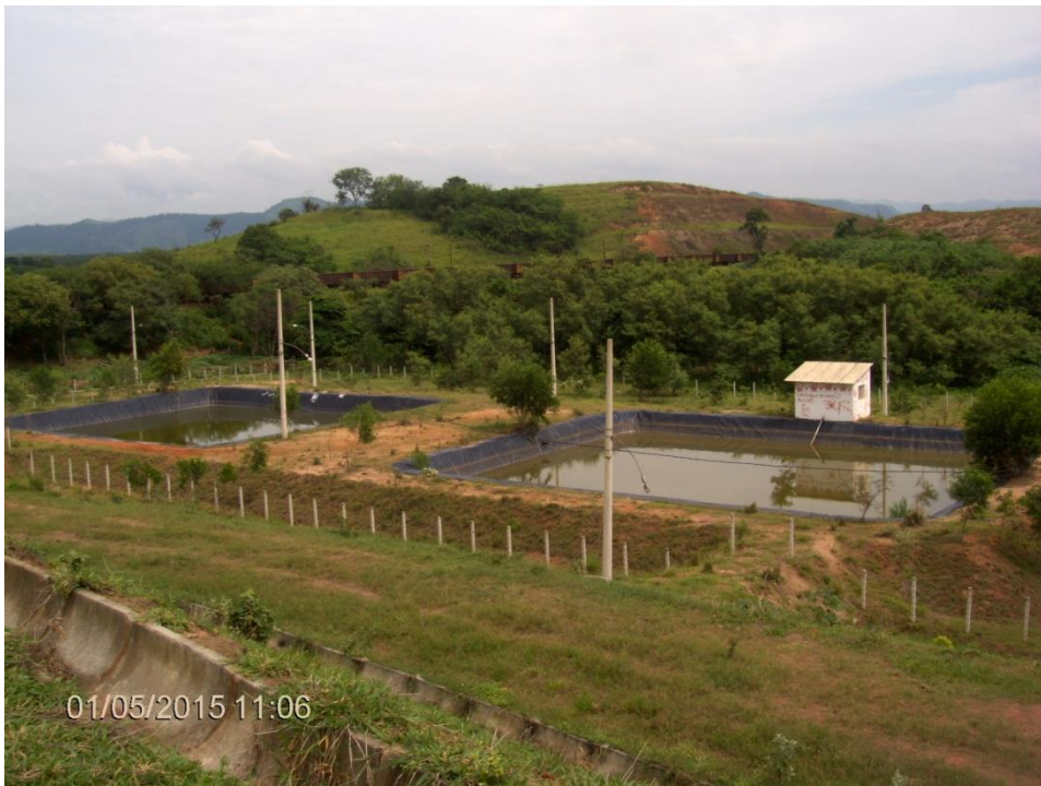
Figura 12 – Vista da lagoa de chorume no aterro remediado do município de Seropédica.
