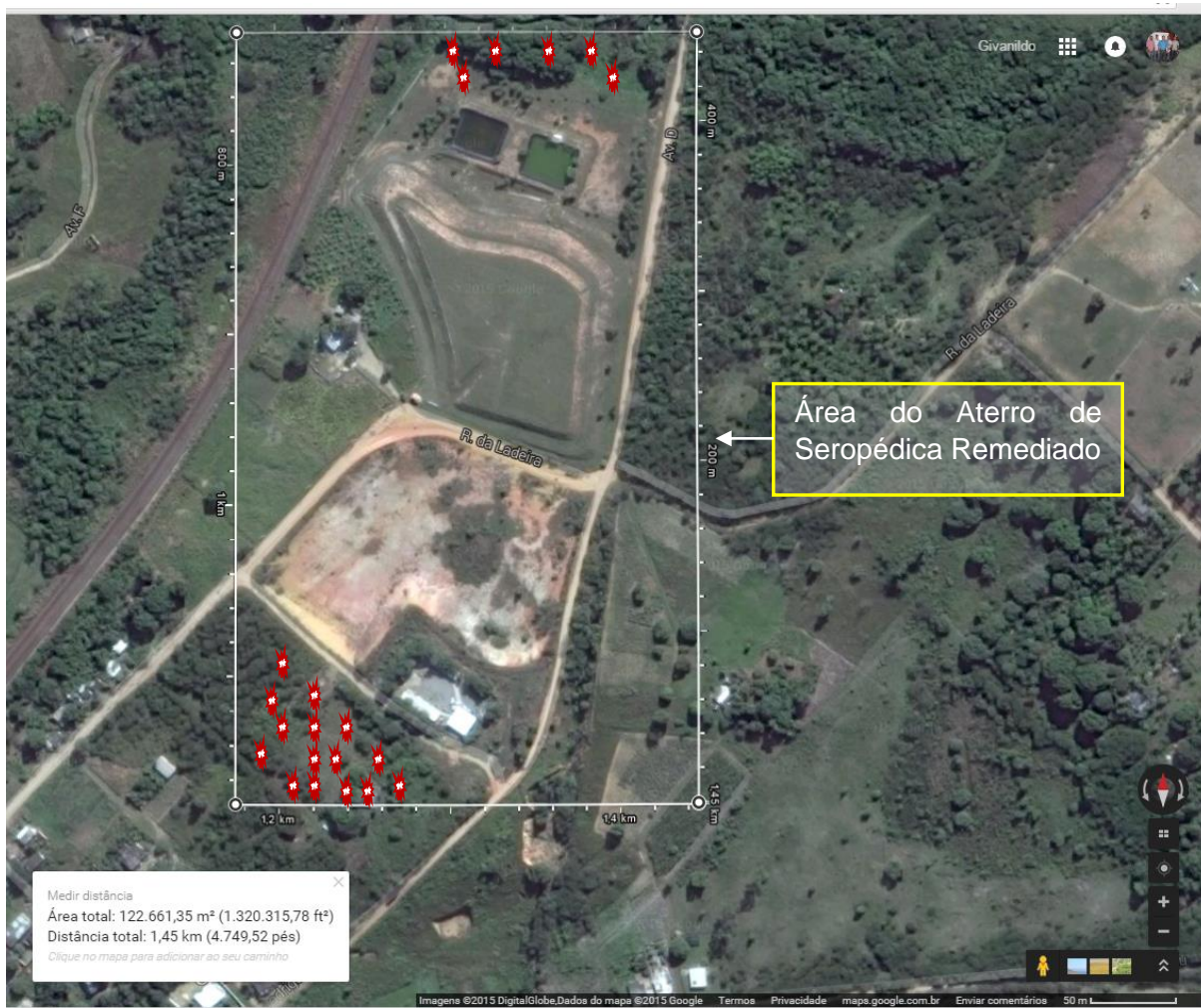
Figura 17 – Localização dos pontos amostrais do Aterro de resíduos sólidos urbanos encerrado de Seropédica.
