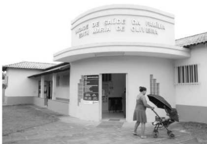
Entrada do Posto de Saúde da Família de São Joaquim, um prédio com ampla estrutura
