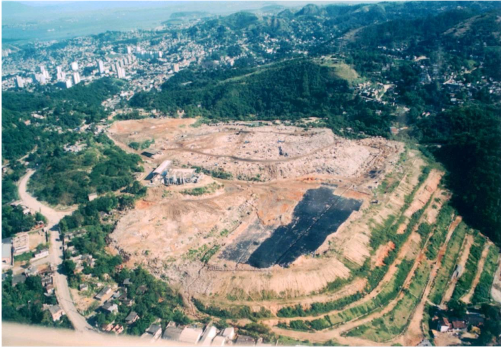
Figura 1 - Vista aérea do aterro do Morro do Céu.
