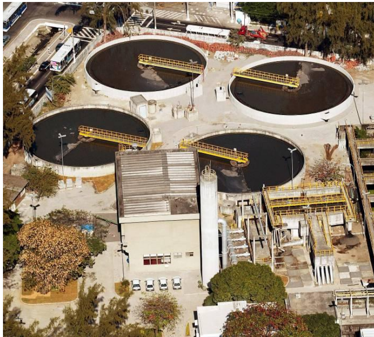
Figura 2 - Vista aérea da ETE Icaraí.
