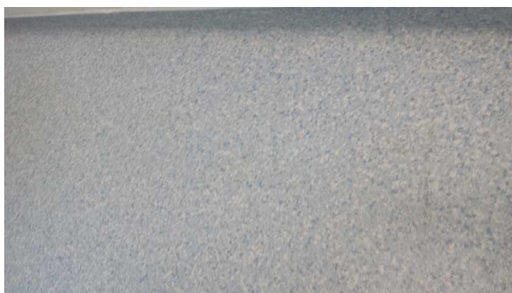
Figura 6 – Piso em manta vinílica homogênea de alta resistência
